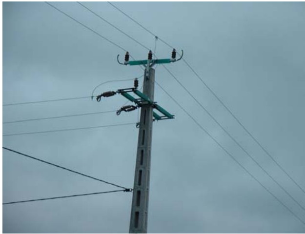
3. kép: Műanyag szigetelő papuccsal ellátott kereszttartó fotó: Somogyi István
