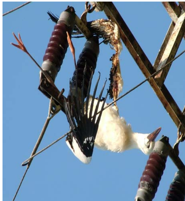
2. kép: áramütött fiatal fehér gólya szigeteletlen vasoszlopon fotó: Utassy Tibor
