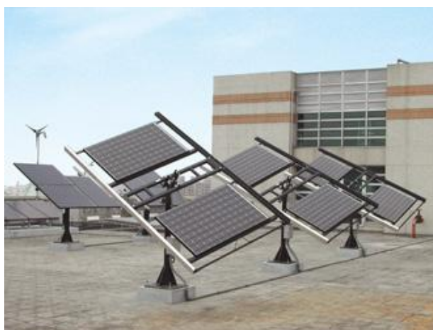
96. ábra: Napkövető állványra szerelt PV modulok
