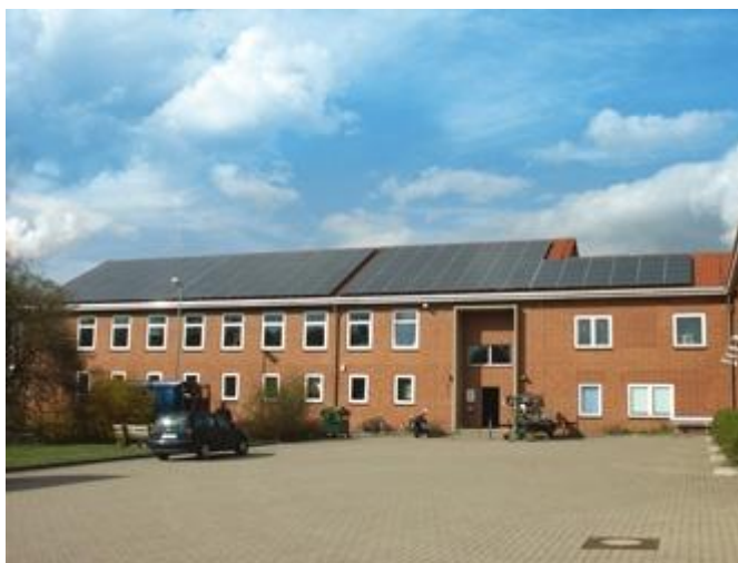
95. ábra: Nyeregtetőre szerelt napelem modulok
