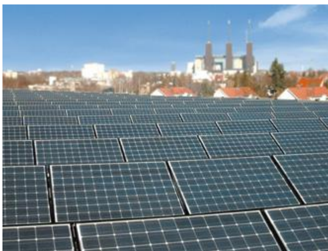
94. ábra: Lapos tetőre telepített PV modulok
